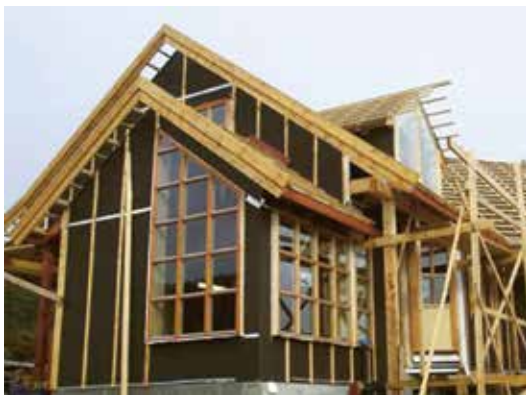
Nyproducerat hus med Hunton Vindtät som vindskydd där Hunton tejp och primer ökar tätheten på klimatskyddet.
