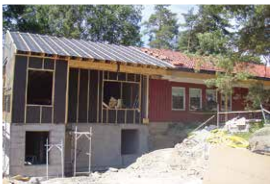
Tillbyggnaden av Sons naturdagem börjar ta form. Hunton Vindtät ser till att byggnaden är tät.
